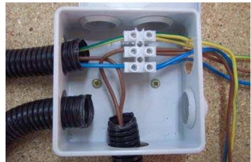
independiente C1 destinado a iluminación requiere de cables de sección  $1,5 \text{ mm}^2$ , mientras que el circuito independiente C3 que alimenta las tomas de cocina y horno requiere de conductores de sección  $6 \text{ mm}^2$ . La sección de los conductores se elige en función de la intensidad de corriente a transportar: a más intensidad, mayor es la sección del cable.
